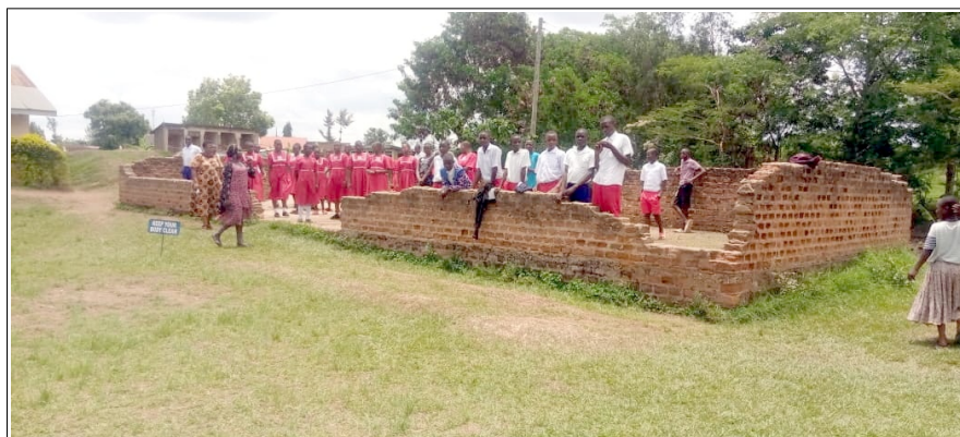
Die Eltern der Schüler der Bussajjabankuba Primarschule in Uganda begannen mit dem Bau eines Klassenzimmerblocks. Leider fehlt ihnen für die Fertigstellung das Geld.
