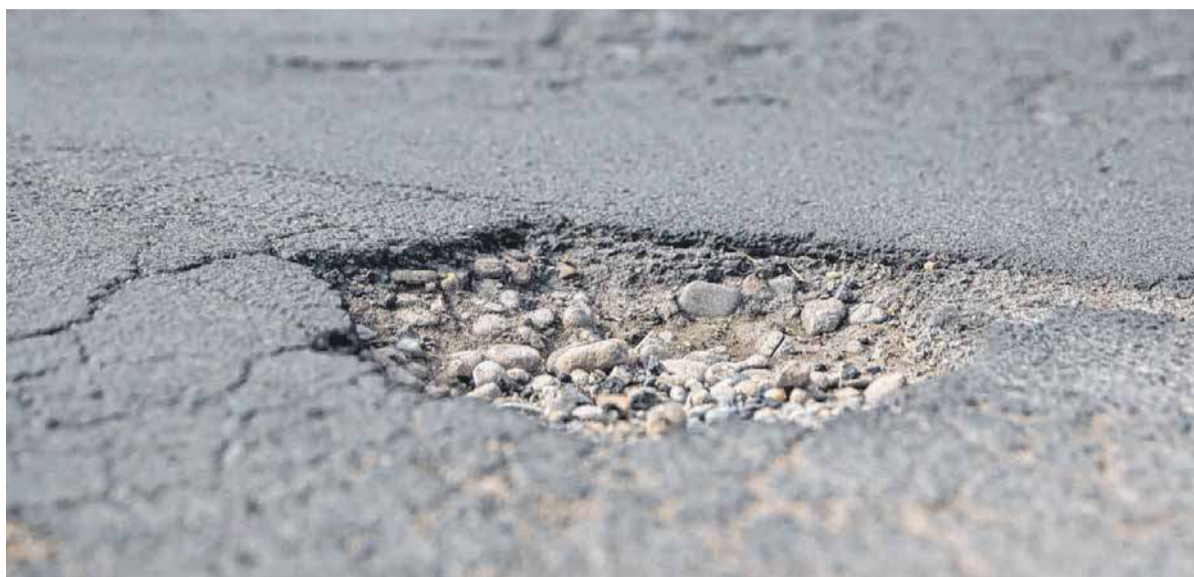
Dauerärgernis: Vor allem Schlaglöcher bereiten den Verkehrsteilnehmern Sorgen.
